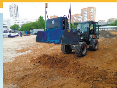
Шаг 6-й. Юстировка системы управления с заданием рабочих отметок
