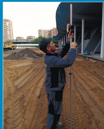
Шаг 5-й. Монтаж лазерного приемника на телескопическую рейку
