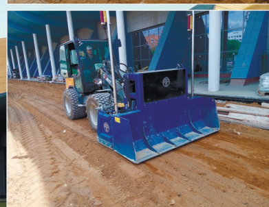
Уплотнение грунта и нивелирование - работа лазерного планировщика в качестве прессы для первичного уплотнения
