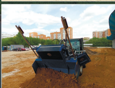
Подсыпка песка - работа лазерного планировщика в качестве фронтального погрузчика
