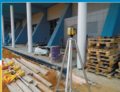
Шаг 4-й. Настройка ротационного лазерного нивелира TOPCON
