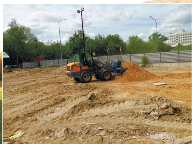
Предварительная планировка песчаного основания — работа лазерного планировщика в качестве грейдера
