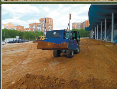
Подсыпка песка - работа лазерного планировщика в качестве фронтального погрузчика
