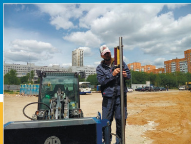
2-й шаг. Монтаж ресиверов (лазерных приемников) TOPCON LS-B110 на мачты из нержавеющей стали
