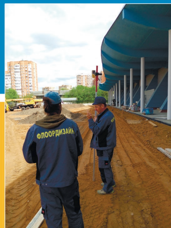
Шаг 6-й. Юстировка системы управления с заданием рабочих отметок
