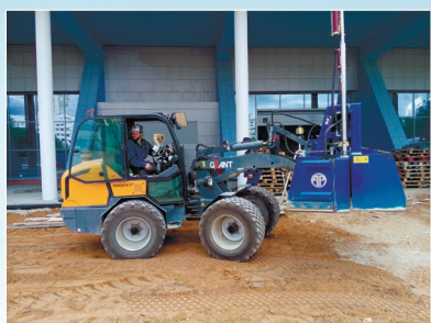
Предварительная планировка песчаного основания — работа лазерного планировщика в качестве грейдера
