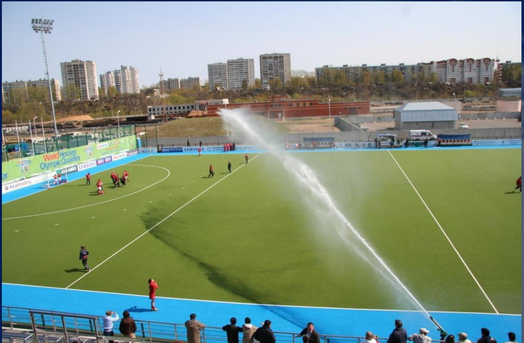
Стадион «Динамо» Екатеринбург, система автоматического полива PERROT (Германия). На фото «стена» воды, равномерный полив всего поля за 10 минут
